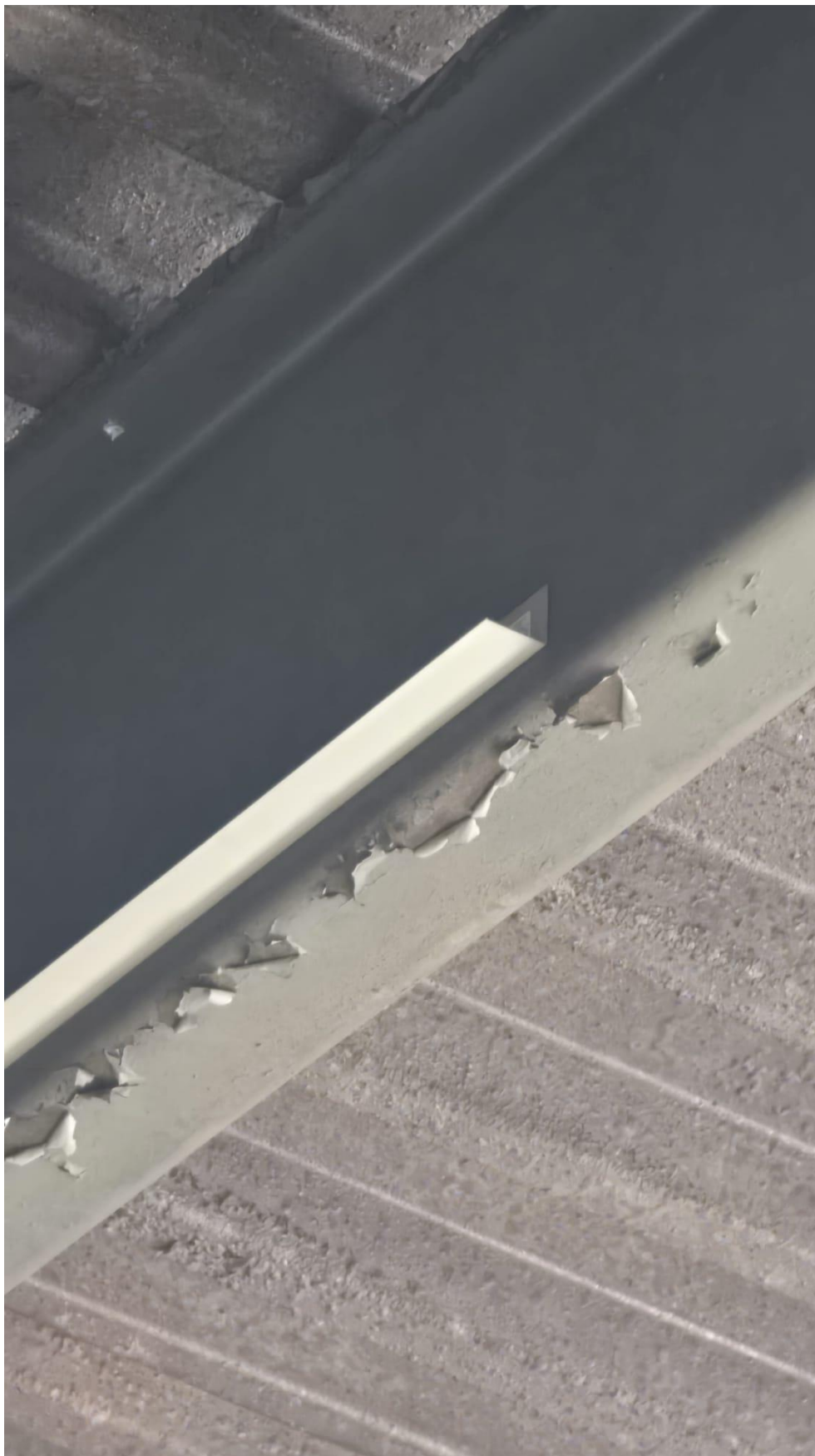
Zdjęcie 10. Szczegół konstrukcji podparcia dla blachy trapezowej z kątownika aluminiowego 50x50x2 (tzw. podkonstrukcji) mocowanej do środka belki stropowej.
