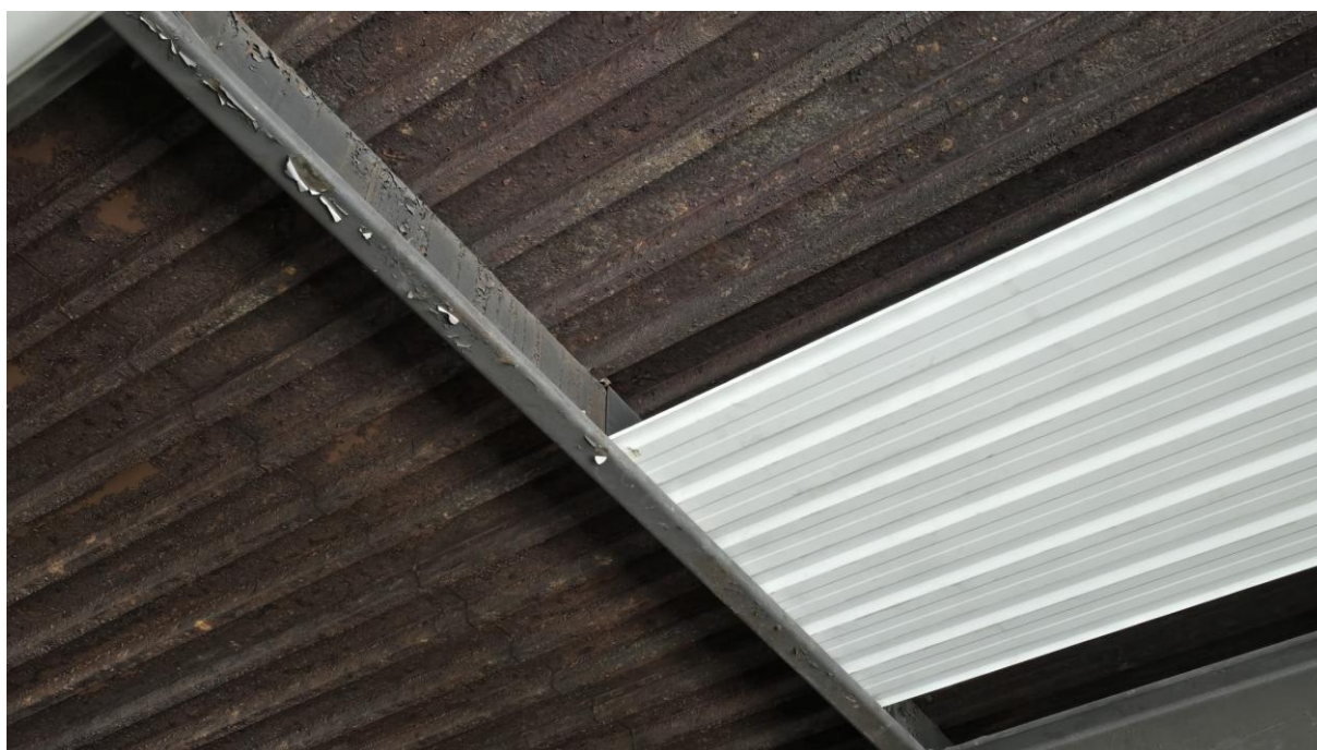
Zdjęcie 9. Szczegół rozwiązania podparcia blachy trapezowej T18 podsufitki na półce dolnej belki stropowej
