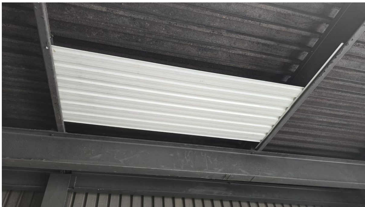
Zdjęcie 8. Rozwiązanie techniczne podwieszanego stropu na hali kotłowej
