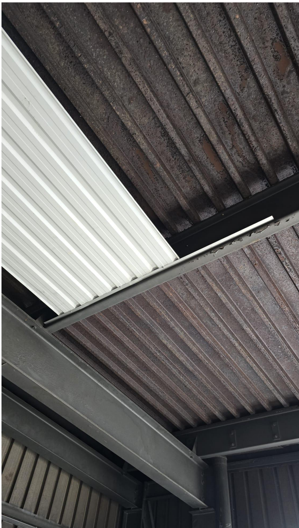
Zdjęcie 11. Podparcie i mocowanie blachy trapezowej T18 podsufitki do gotowej podkonstrukcji
