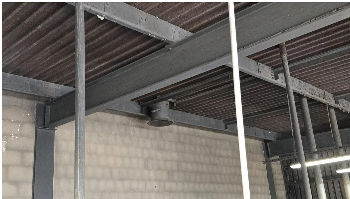
Zdjęcie 5. Widok belek stropowych, dachu i wywietrzaka dachowego Ø 400 – stan istniejący
