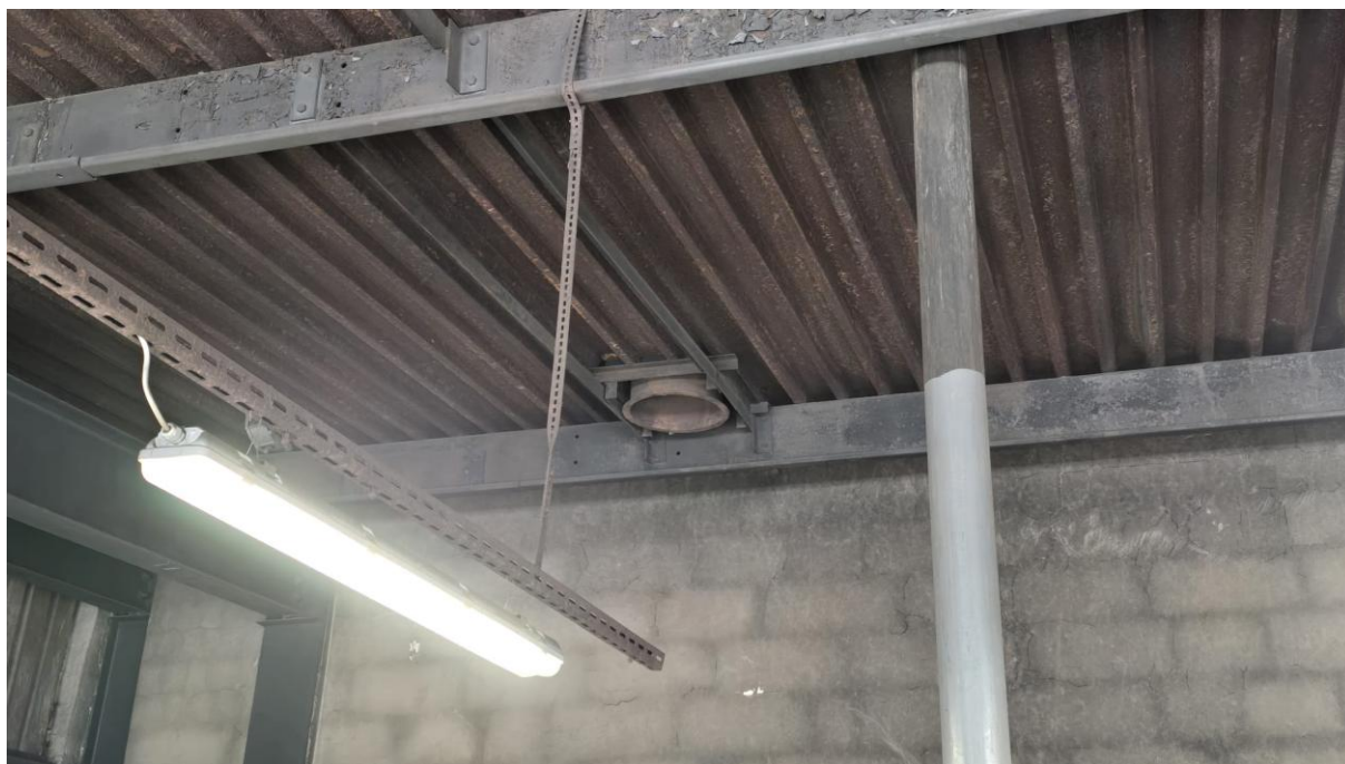
Zdjęcie 7. Widok belek stropowych, dachu i drugiego wywietrzaka dachowego Ø 400 koniecznego do przedłużenia poza płaszczyznę podsufitki – stan istniejący
